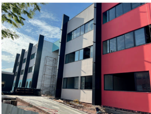
Segundo o DER-ES, obra na Escola Aristóbulo Barbosa Leão está na fase de acabamento. Crédito: Vítor Jubiléi.
