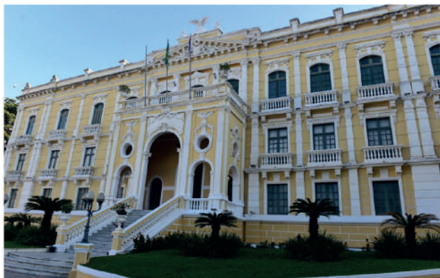
Palácio Anchieta: governo do Estado vai repassar recursos às cidades para obras de prevenção e reconstrução. Crédito: Ricardo Medeiros
